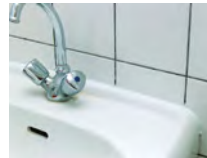
ПІСЛЯ видалення старого силіконового герметика
